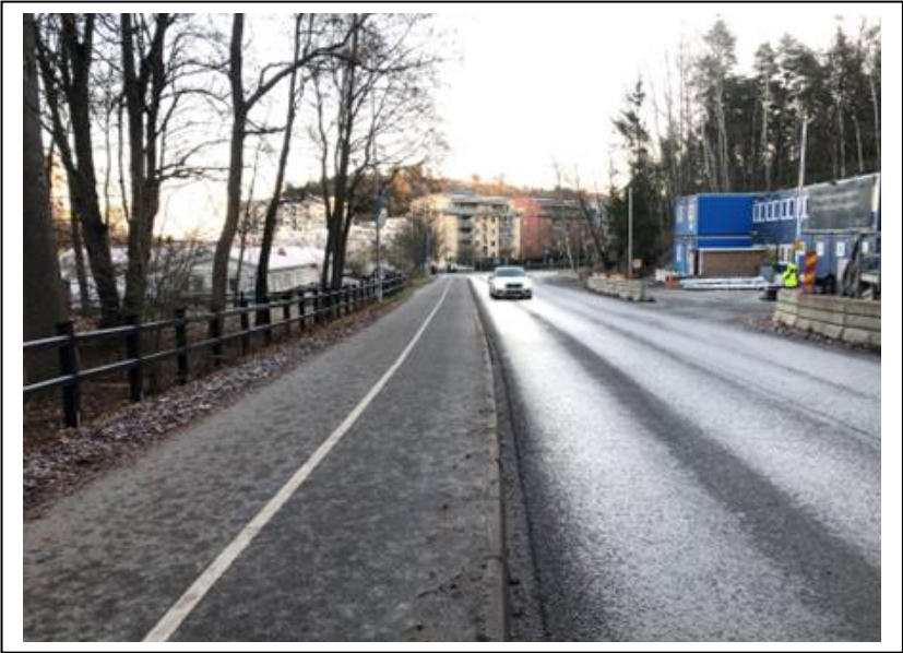
Figur 96. Smal gång- och cykelbana utmed Kvarnholmsvägen.
