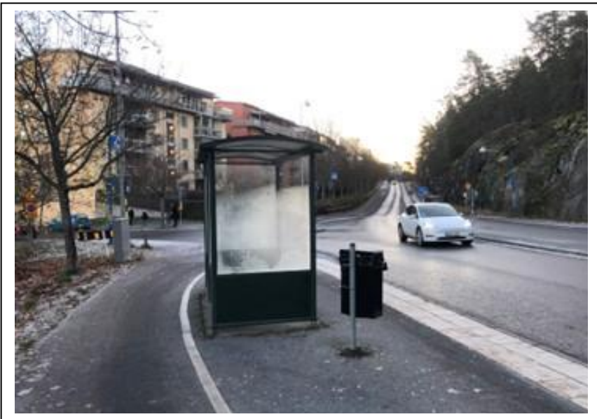
Figur 101. Snäv och smal cykelbana bakom väderskydd med bristfällig sikt invid korsningen invid Finnboda Varvsväg.
