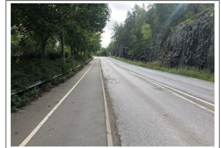
Figur 105, Smal gång- och cykelbana utmed Kvarnholmsvägens norra sida.
