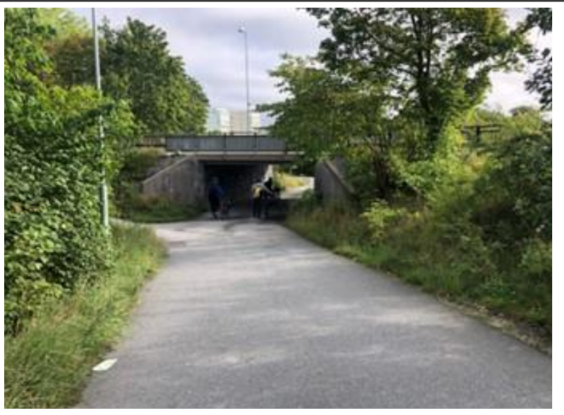
Figur 90. Gång- och cykeltunnel under Danvikshemsvägen.
